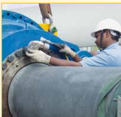
▲ Serraggio di segmenti di ingranaggi.
