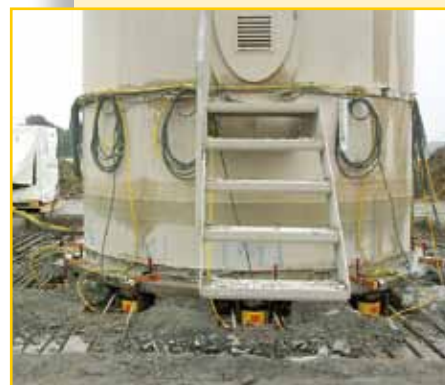
Riallineamento di fondamenta di turbine ▼
